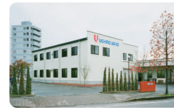
02 長岡市の工業施設
