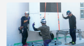
長岡信金宮内店機械設備工事
