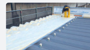
中越キカイ工場棟屋根断熱化工事
