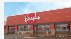
ファサード外壁修繕工事
