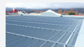
雪害修繕工事
