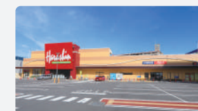
原信関屋店増改装工事及び店舗内装工事
