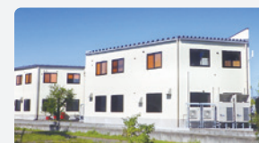
株式会社内野精工 長岡第三工場増築工事
