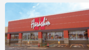
ファサード外壁修繕工事
