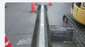
除雪第3号千谷川平沢線消雪パイプ布設替工事
