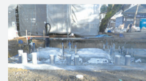
機那サラン酒本舗酒蔵改修設備工事
