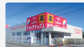
ドラッグトップス村上前町店増改築工事
