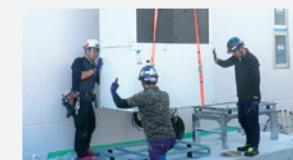
長岡信金宮内店機械設備工事
