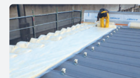
中越キカイ工場棟屋根断熱化工事
