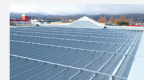
雪害修繕工事
